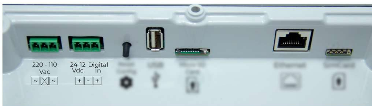
Figura: Conexão dos cabos alimentadores
