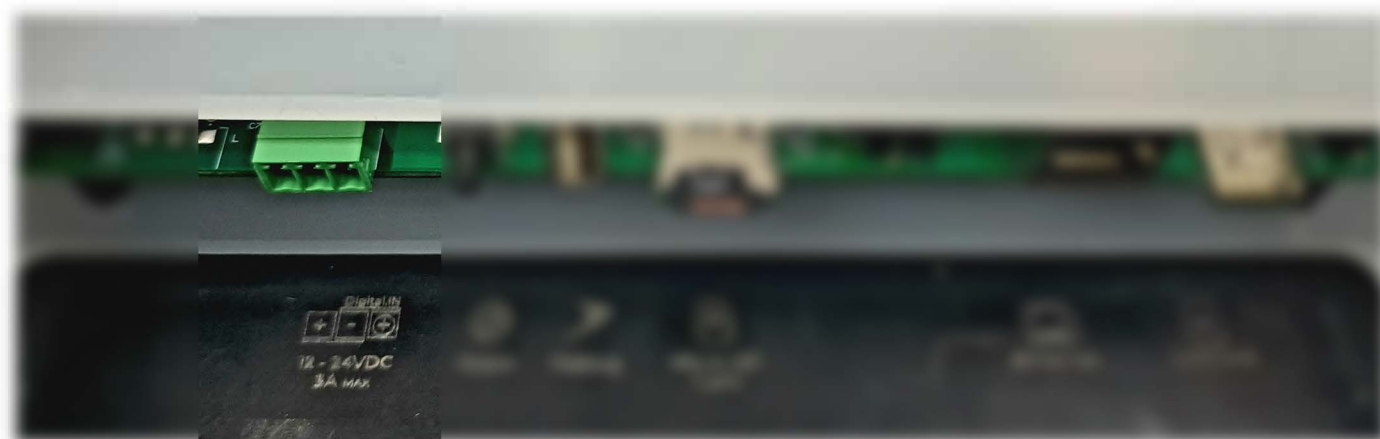
Figura: Conexão dos cabos alimentadores
